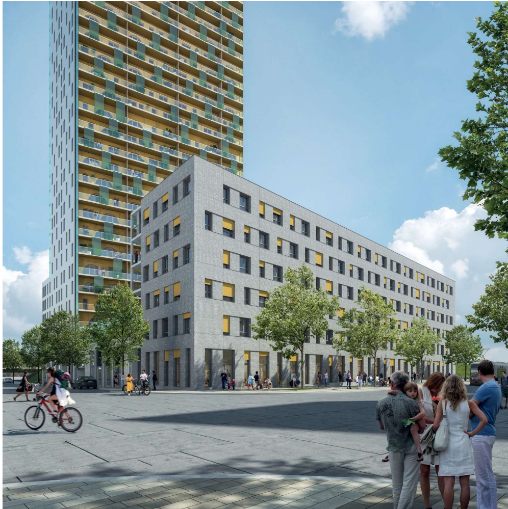
Loft-Fassade an der Ecke Taborstraße/ Bruno-Marek-Allee
