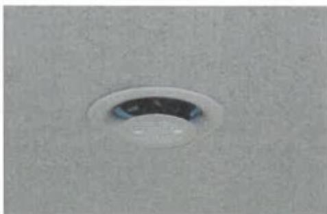
Abbildung 2 - Sprinklerkopf
